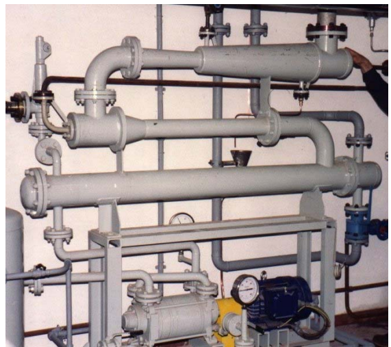
De dos etapas con bombas de vacío e intercambiador de superficie
